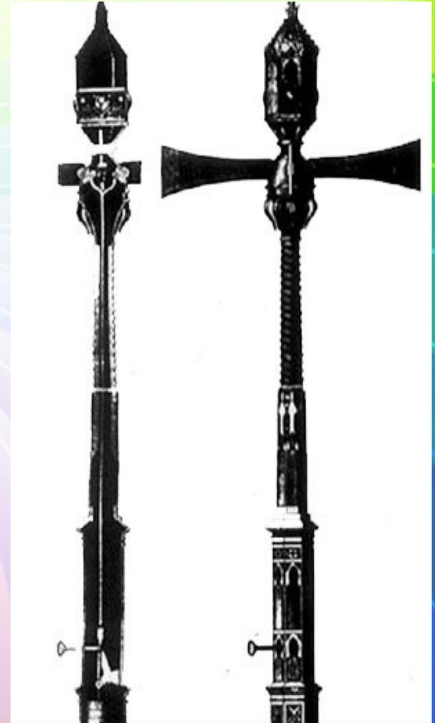
Когда стрелки располагались горизонтально, автомобилям запрещалось проезжать, а положение на 45 градусов означало разрешение движения.
